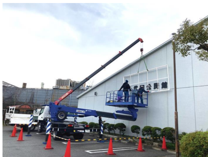
看板は2月19日(月)にクレーン車で設置。
