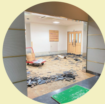
かつらぎ北病棟 1階
